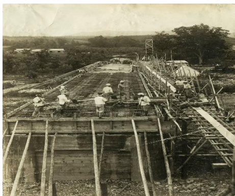
叶橋工事の様子 (昭和9年)
