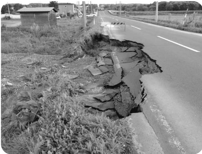
8月の豪雨で路肩崩壊の被害を受けた相内線
