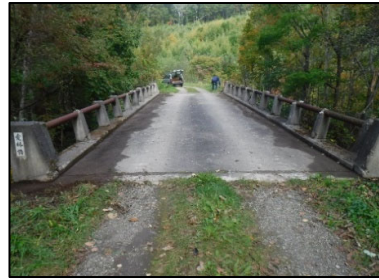
【全景：起点側から】
