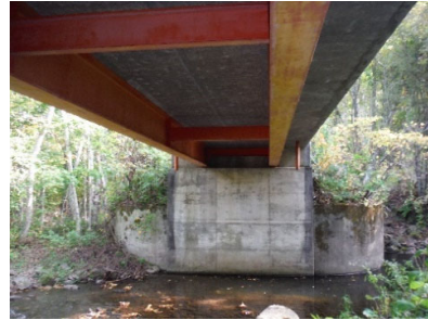
【橋台:A1橋台】
