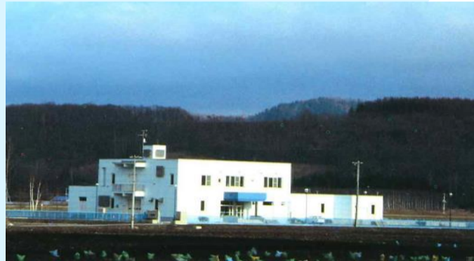
訓子府町農業集落排水管理センター
