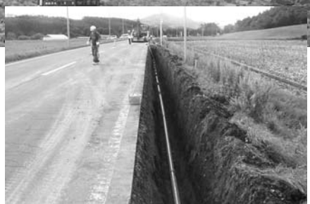
南部地区の客土完了後（上）と営農用水管路整備工事（右）
