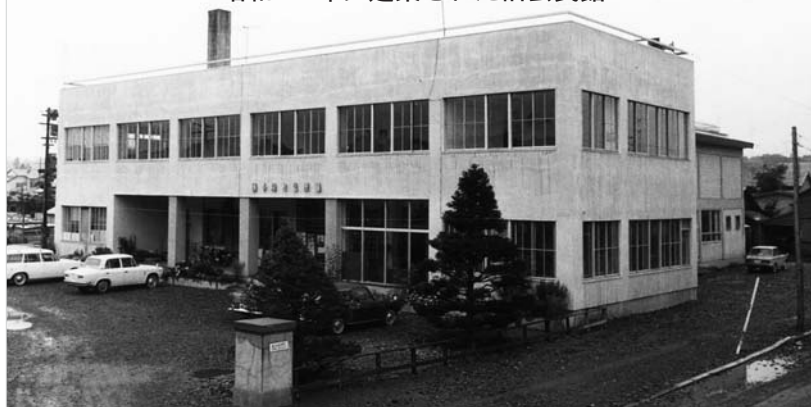
昭和 37 年に建築された旧公民館
