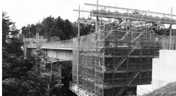
開盛の道有林内で建設中の三豊橋（仮称）
