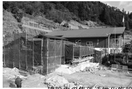
建設中の集落活性化施設
