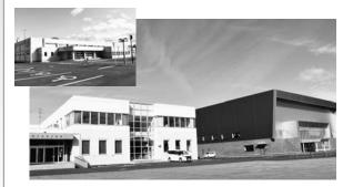
新スポーツセンターの外構工 事に合わせて、公民館と温水プー ルの外構の一部を整備し、駐車場 や緑地の拡充などを行い、利用者 の利便性を図りました。外構面積 5,879.6 ㎡で7月に完成しました。 このほか、建設後24年が経過 した温水プールの屋上防水工事 を行い、施設の長寿命化を図りま した。工事は、9月に完了しまし
