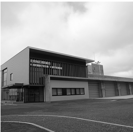
着々と工事が進む消防庁舎
