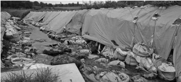
山林川被災現場
