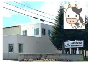
JAきたみらい生産資材拠点センター
