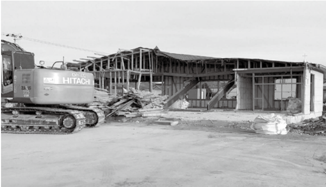
消防庁舎建設用地では既存施設の解体が進む(4月6日)
