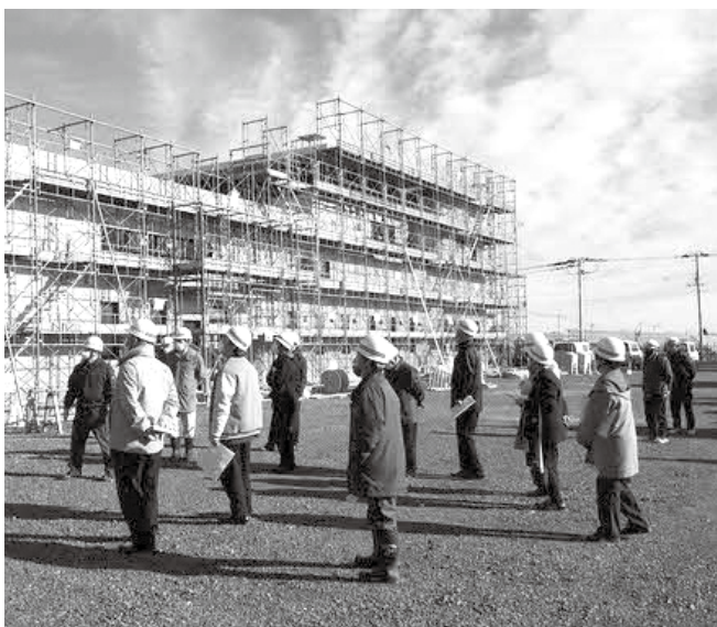
新しい防災の拠点作りが着々と進む
