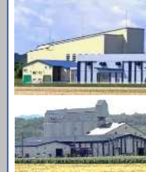
28. JAきたみらい倉庫団地
